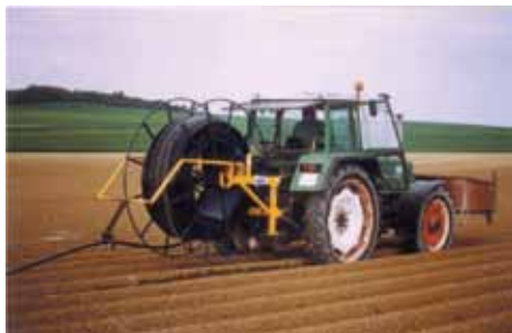
Монтаж системы IrriStand
